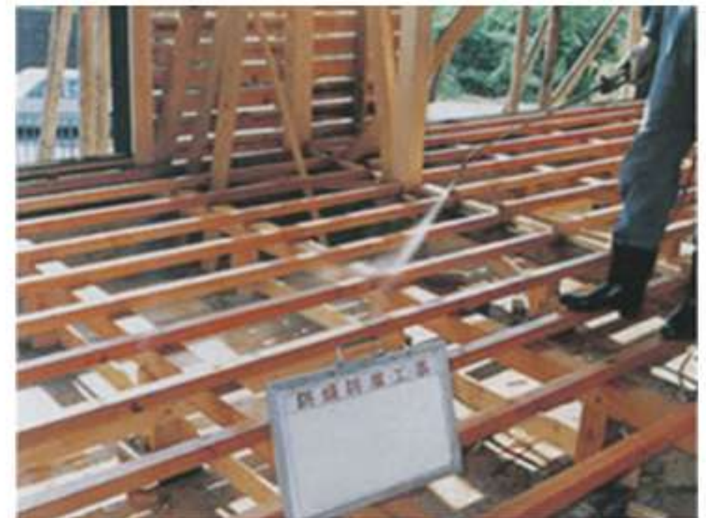
▲吹付処理の様子
